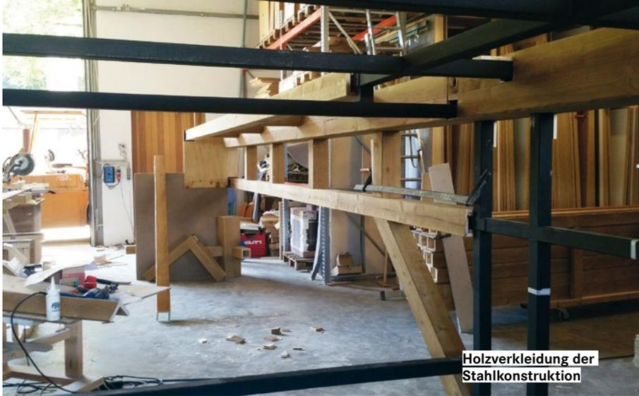
**Holzverkleidung der Stahlkonstruktion**
