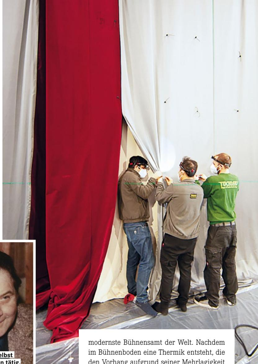
modernste Bühnensamt der Welt. Nachdem im Bühnenboden eine Thermik entsteht, die den Vorhang aufgrund seiner Mehrlagigkeit aufblähen würde, wurden die vorderste und die letzte Stofflage miteinander verbunden.
