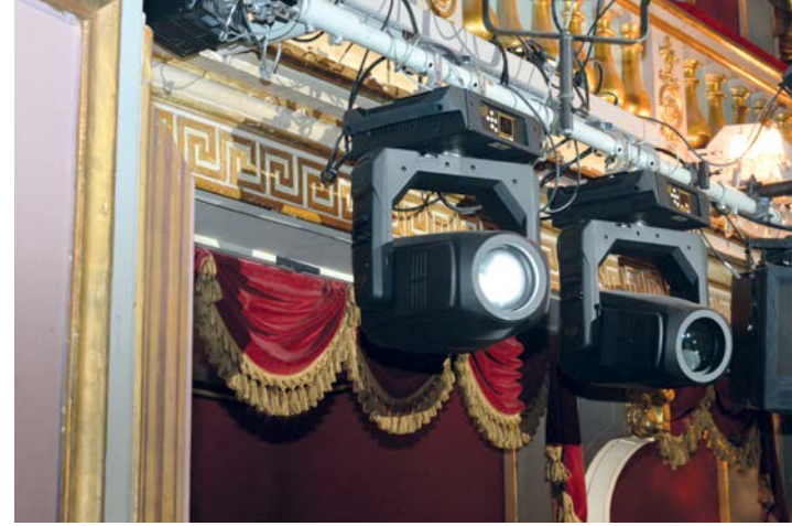
Die neuen LED-Moving-Heads SolaFrame 750 der Marke High End Systems sind rechts und links über dem Orchester an den Brüstungen der Parkettlogen montiert.
