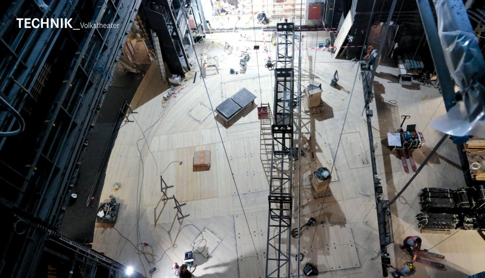
29 Prospektzüge auf der Bühne und 5 auf der Hinterbühne sind bereits verbaut, nun muss nur noch die Steuerung feinabgestimmt werden.
