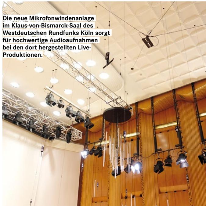
**Die neue Mikrofonwindenanlage im Klaus-von-Bismarck-Saal des Westdeutschen Rundfunks Köln sorgt für hochwertige Audioaufnahmen bei den dort hergestellten Live-Produktionen.**
