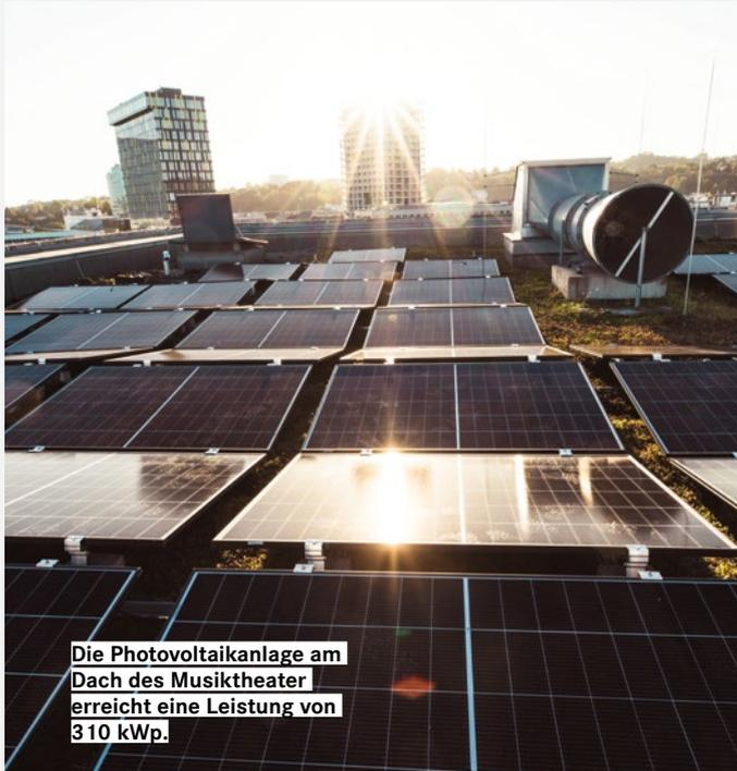
Die Photovoltaikanlage am Dach des Musiktheater erreicht eine Leistung von 310 kWp.
