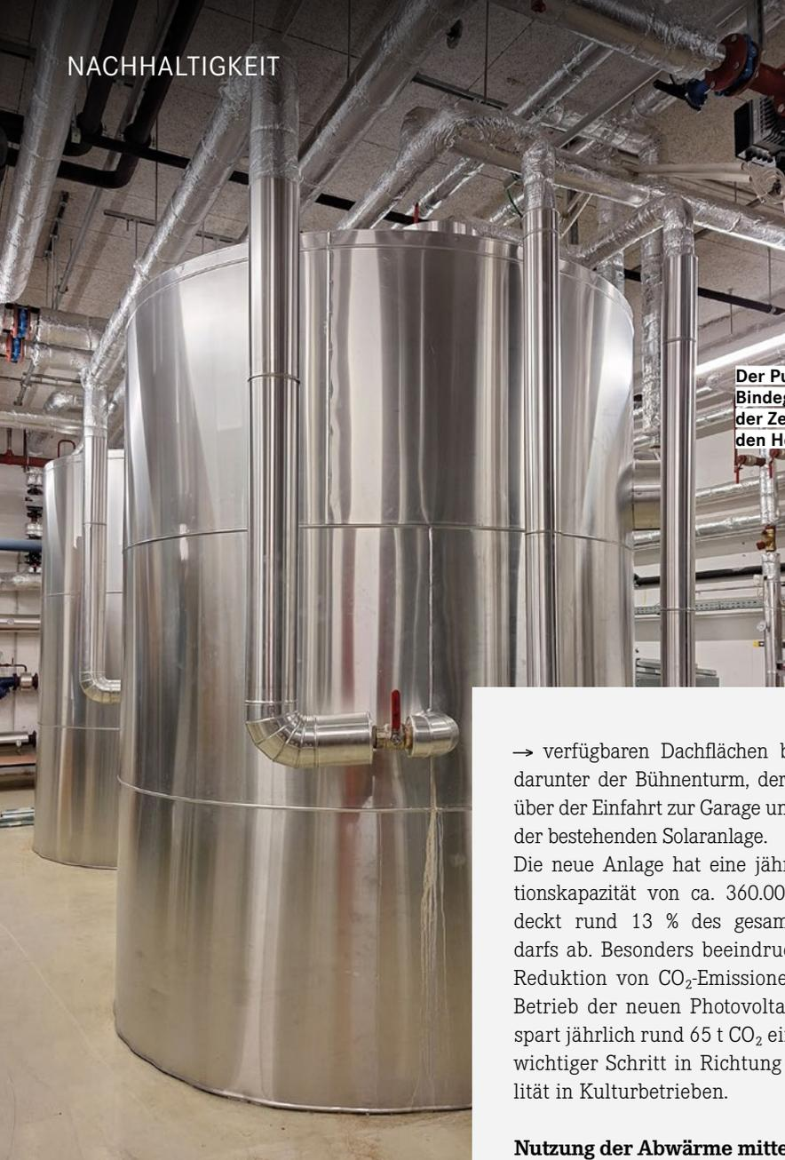
**Der Pufferspeicher ist das Bindeglied zwischen der Zentralheizung und den Heizkörpern im Haus.**
